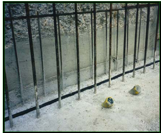
Waterstop en arranque de muro fijada con adhesivo
